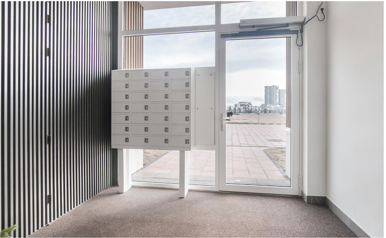
Ingang appartementencomplex met de ENTRAX EW400
